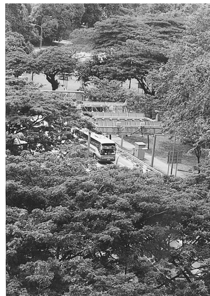
写真1 都心への道路に設置されたガントリー（バスが通過中）
